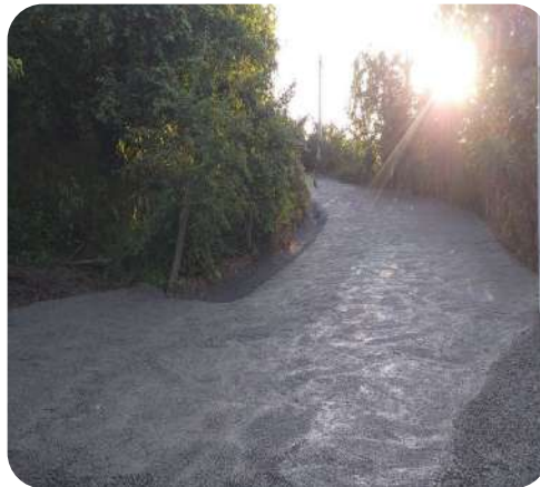
Beton Yol Çalışmaları
