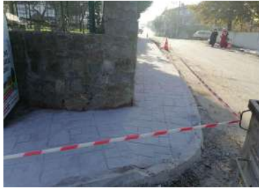
Bordurmatik ve Kaldırım çalışmaları
