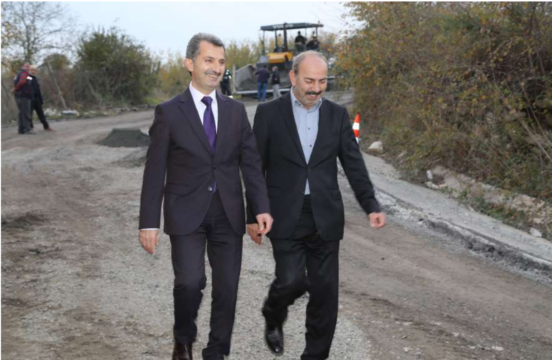
Hızır Mahalle Çevre Yolu (Beton Yol) Çalışması
